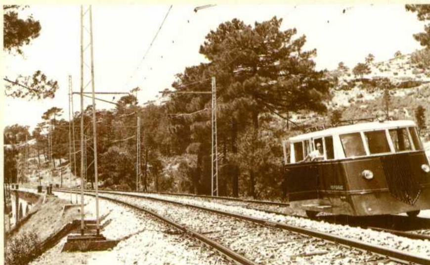
Vagoneta de Vía y Obras en la línea Madrid-Irún.
