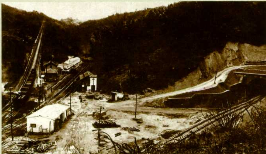
Las vías mineras tienen ancho de 60 centímetros.
