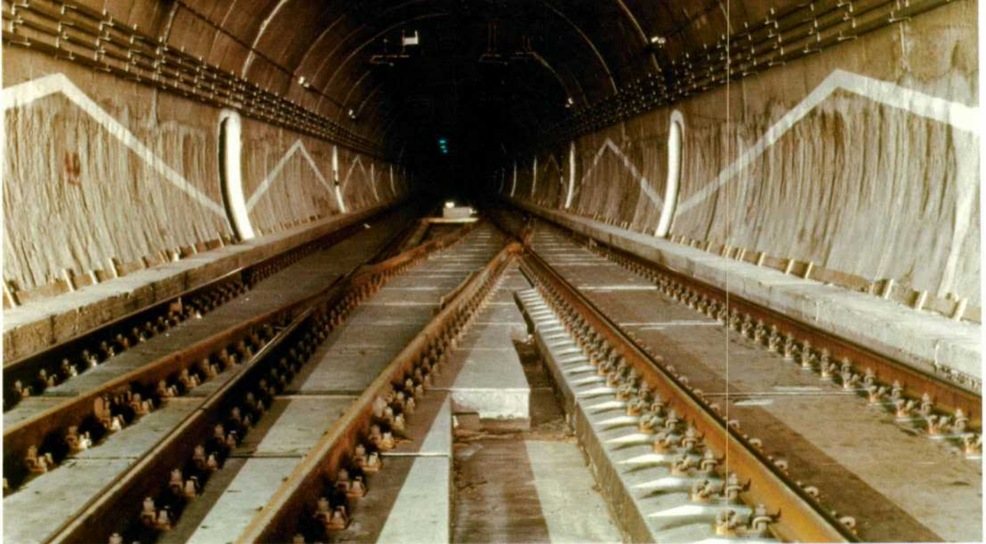
Vía sin balasto Ipa instalada en un túnel
