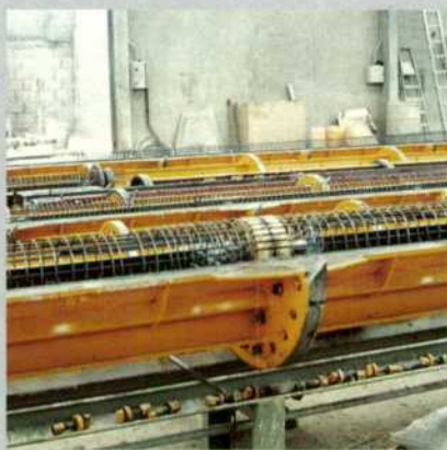
Molde preparado con armadura.
