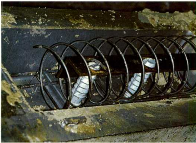
Armaduras y huecos de los tirafondos.
