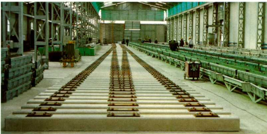
Aspecto general de la nave de pretensado.
