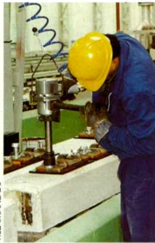
Colocación de las placas.
