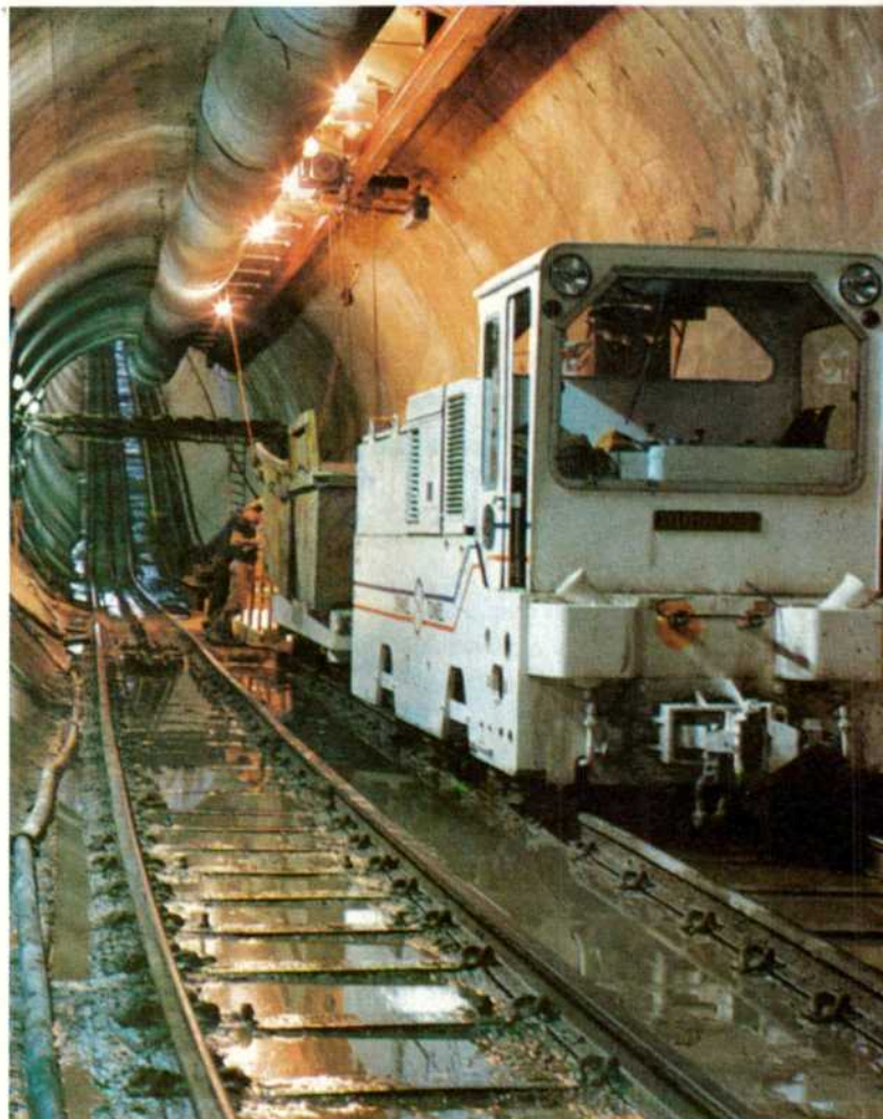
Primer tren del túnel bajo el Canal de la Mancha
