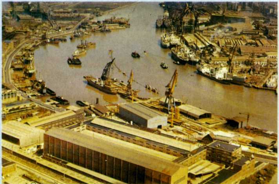
Erandio, la segunda fábrica más grande de Cenemesa, produce generadores de energía eléctrica y equipos de control de tracción.
