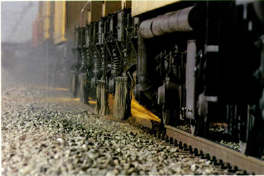
Las exigencias de la alta velocidad son muy estrictas con la plataforma, lecho de balasto, traviesas y carriles.
