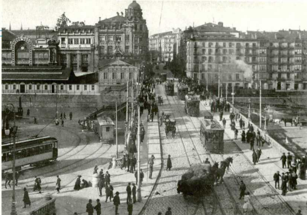
Vista de la estación del Bilbao-Portugalete en tiempos de la tracción vapor.
