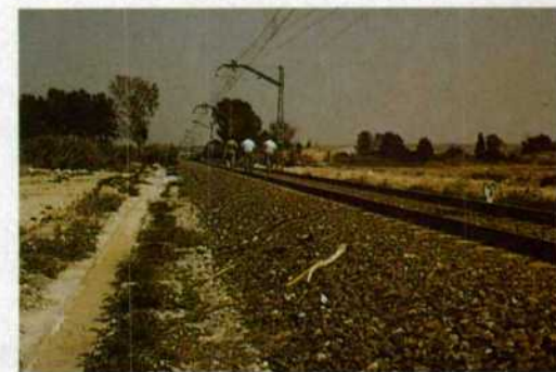
Pantalla de bentonita-cemento en la línea Zaragoza Barcelona.
