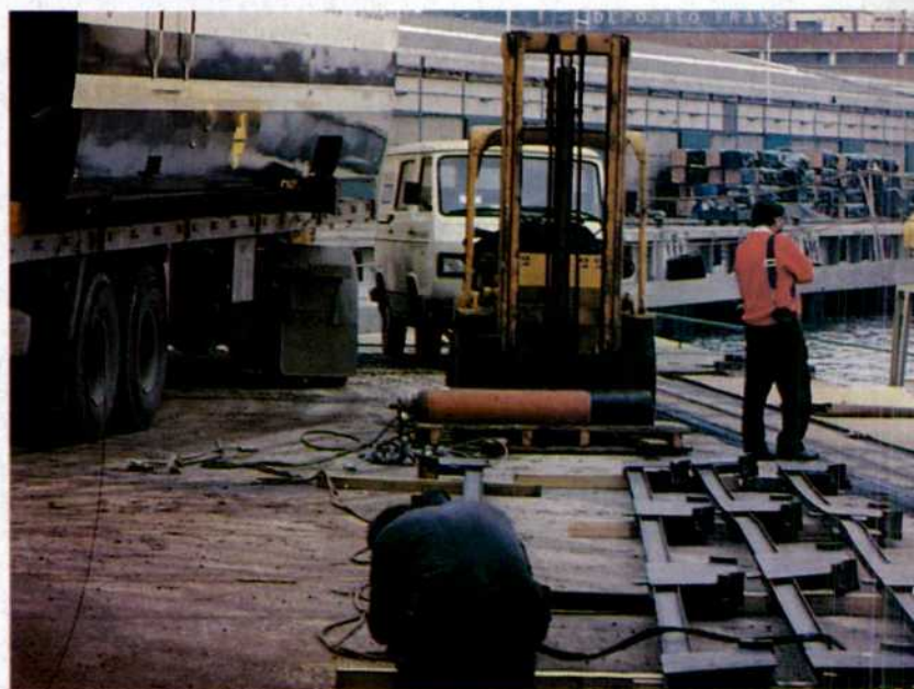
Soldando los elementos de anclaje.
