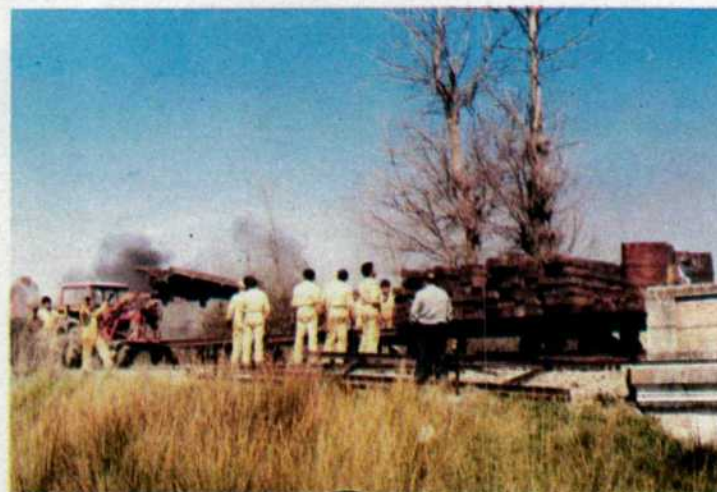
Tramo IV, cerca de Malagón. Desguace «in situ». Carga de traviesas sobre la composición de diplotrys (15-III-88).
