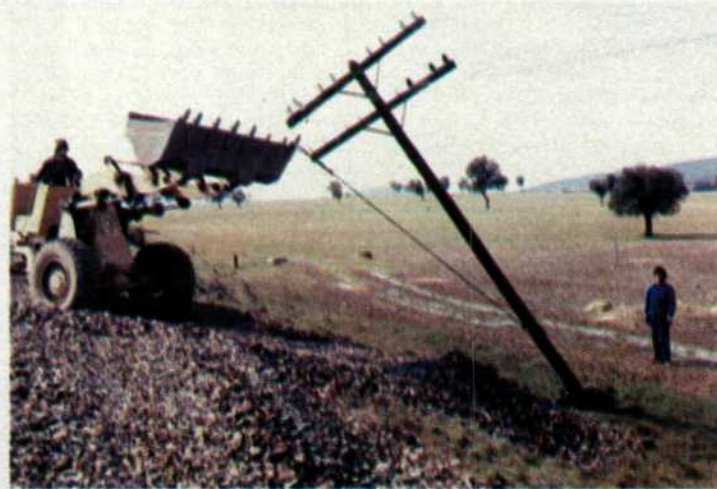
Retirada de la línea de comunicaciones en el tramo III. Levante y tumbado de los postes (3-III-88).
