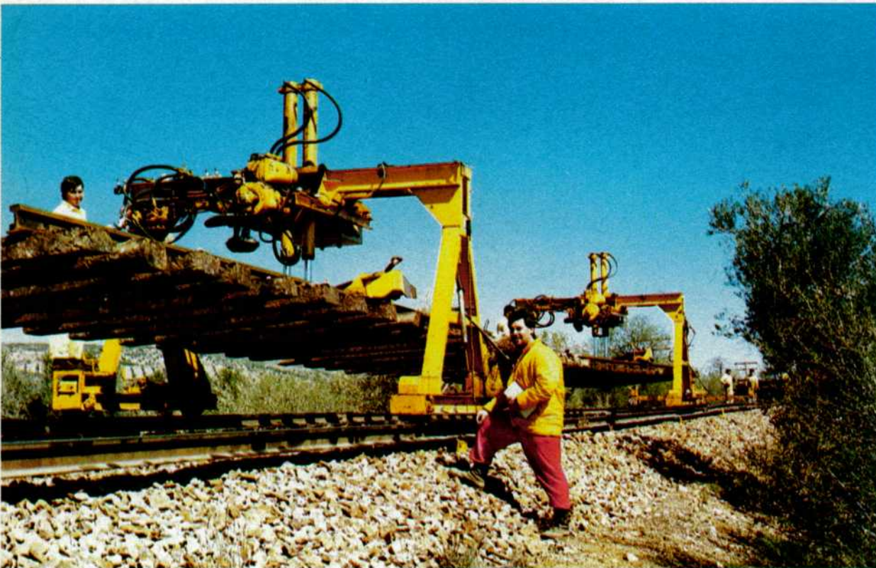
Rampa entre Los Yébenes y Mora. Levante mediante pórticos, tramo III (15-3-88). Una pareja de vía de 24 metros «vuela» en brazos de los pórticos hacia el tren de los trabajos.
