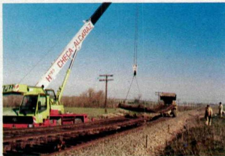
Levante de parejas de 22 metros en el tramo I, pasado Yeles. El sistema utilizado es el de levante con grúa (15-III-88).
