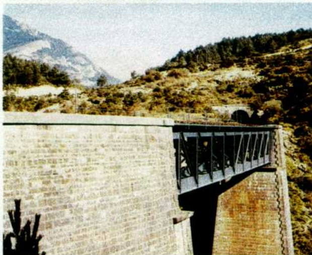
Tramo metálico en el punto kilométrico 16/682 de la línea Jaca-Canfranc.
