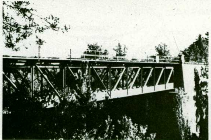
Estructura metálica sobre el río Aragón en el punto kilométrico 9/811. En Bedous, comienza la parte montañosa del tramo.
