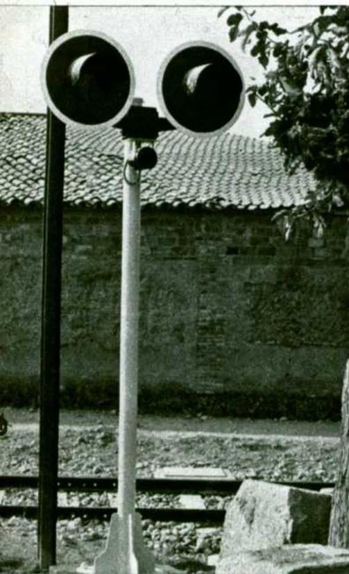
Paso a nivel automático en el kilómetro 11,796 de la línea Lérida-Pobla de Segur, durante su fase de instalación.
