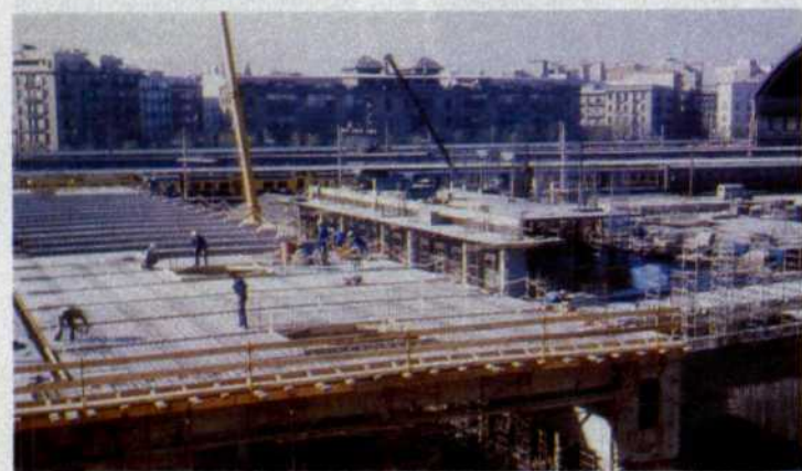
Colocación de armaduras y del alero de la cubierta. En el centro se observa el elemento de paso del intercambiador al aparcamiento de la cubierta de la NECA (diciembre 1986).
