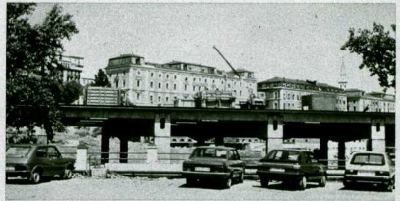
La NECA y los edificios de RENFE de la Avda. de Ciudad de Barcelona desde las vías de Atocha. En el futuro, la cubierta del aparcamiento no permitirá ver estos edificios.
