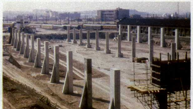
Panorama de los pilares y pilas de la NECA. Hay 15 metros de separación entre cada dos en sentido longitudinal y 38 metros en sentido transversal (septiembre 1986).
