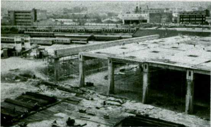
Conclusión de la última viga de la cubierta (2 de abril de 1987).
