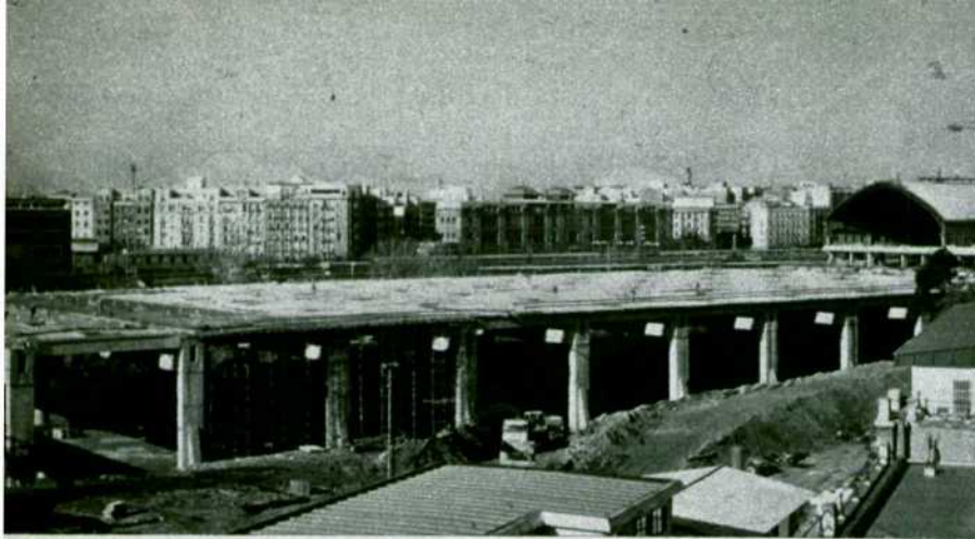
Aspecto de la cubierta de la NECA antes de hacer las boquillas de los lucernarios (21 de febrero de 1987).
