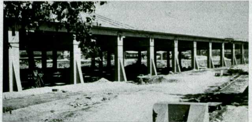
Vista de la parte Oeste de la NECA desde la zona en que se encontraba el autoexpreso. Está acabada prácticamente la cubierta (5 de mayo de 1987).
