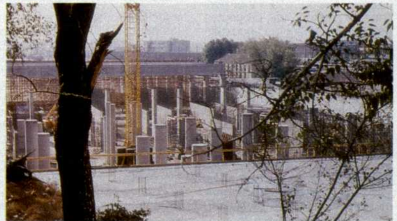
El acceso al intercambiador desde uno de los árboles del jardín del antiguo Laboratorio. Al fondo, viga de cubierta de la NECA (septiembre 1986).
