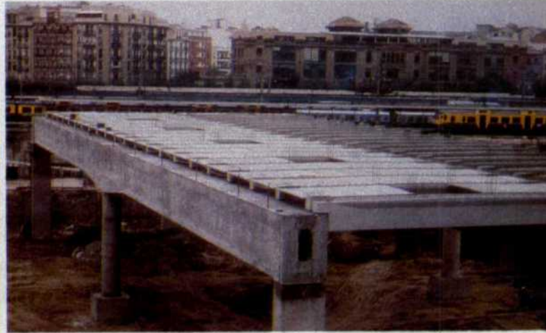
Sobre las viguetas de la cubierta se colocan unas placas de hormigón prefabricadas sobre las que se colocará la necesaria armadura y capa de compresión de homigón (octubre 86).
