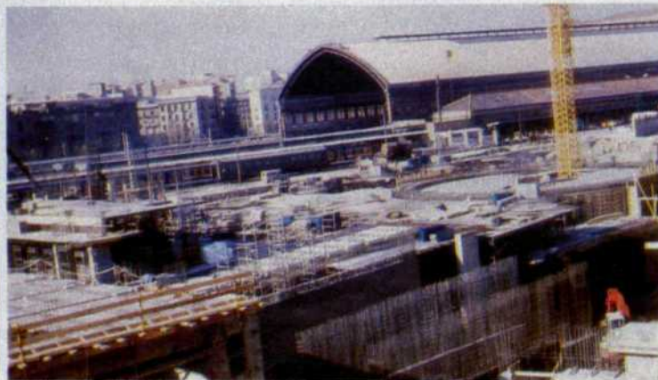
El intercambiador, con su estructura cilíndrica. En primer término, las armaduras delimitativas de las escaleras de acceso a los andenes (diciembre 1986).
