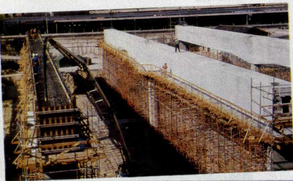
Fabricación «in situ» de una de las vigas de cubierta (septiembre 1986).
