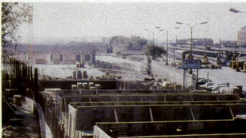
Construcción de las rampas peatonales de acceso al intercambiador. Los muros en primer término son de aligeramiento de la estructura (septiembre 1986).
