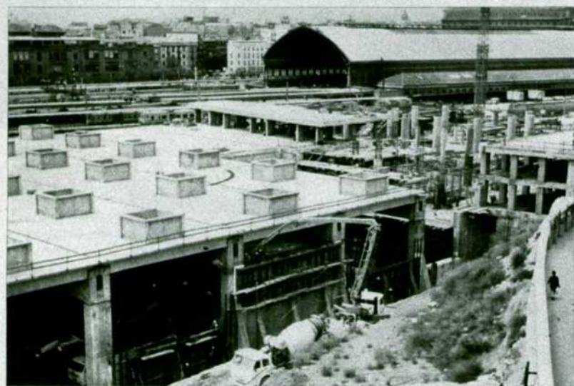
En primer término se observa el hormigoncillo del primer hueco del cerramiento. Se ven tanto los lucernarios como el avance del intercambiador (27 de abril de 1987).
