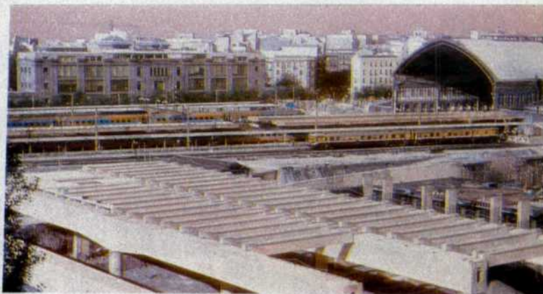
Se comienza a realizar la cubierta colocando entre las vigas principales, vigas prefabricadas de unos 14 metros de luz, separadas entre sí unos cuatro metros (octubre 1986).
