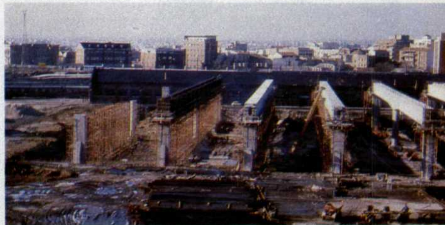
21 de febrero de 1987. Todavía faltan dos vigas por construir.
