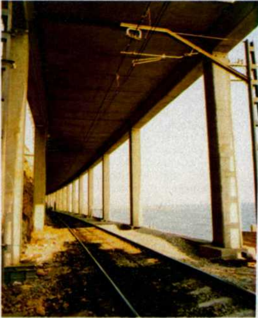
Túneles Garraf (Barcelona)
