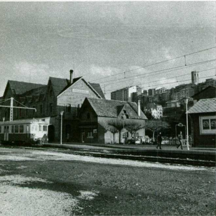
Estación de Puigcerdá.
