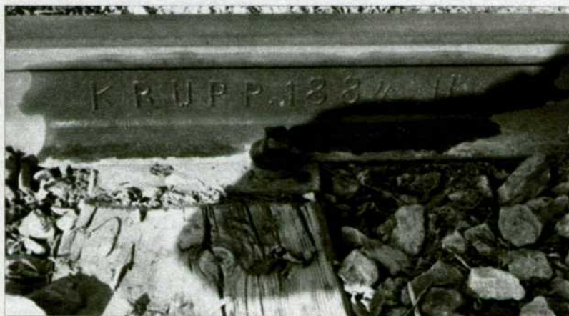
Carriles Krupp 1884 en vías secundarias. Alhama de Murcia, 1984.
