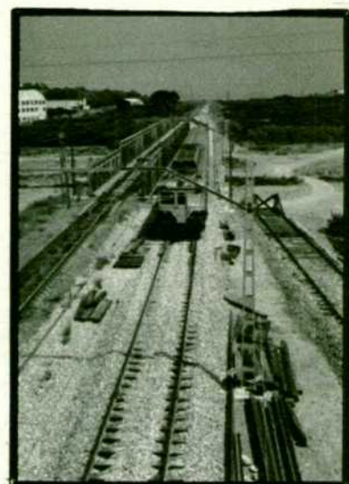
Puente sobre el Palancia a la salida de Sagunto.
