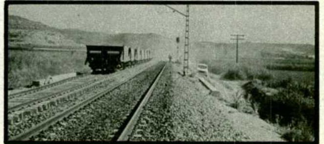
Descarga de balasto en la nueva vía ya colocada, trayecto Arcos de Jalón-Santa María de Huerta.
