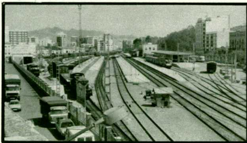
Vista panorámica de la estación de Castellón, en abril de 1982.
