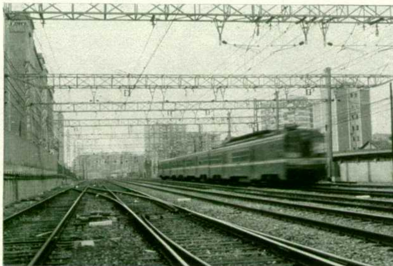
Hasta el verano del 83, la línea de contacto, de tipo poligonal, se hallaba sin compensar y sustentada mediante pórticos funiculares.
