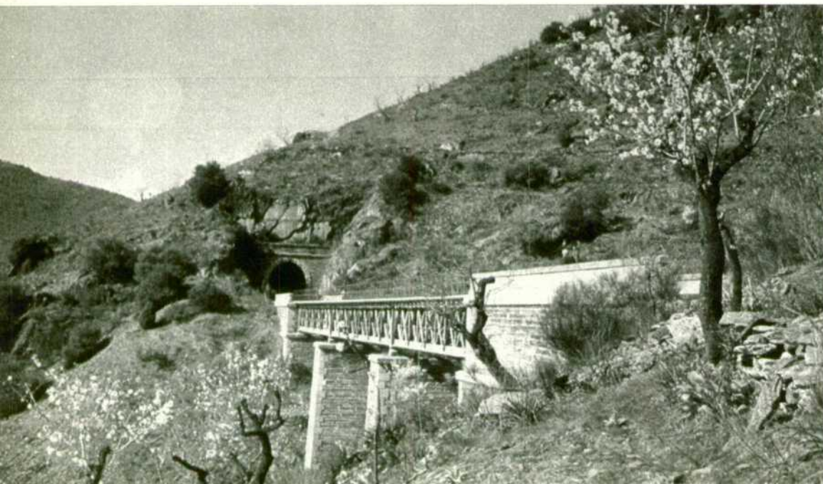
Puente del arroyo de los Riscos.
