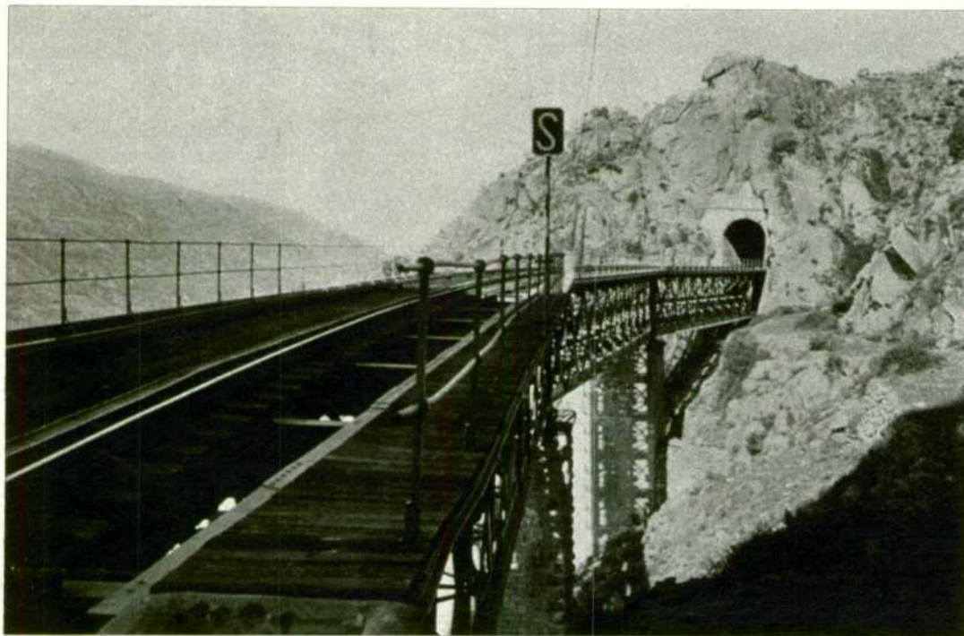
Puente sobre el arroyo de Poyo Valiente. Está entre dos túneles.
