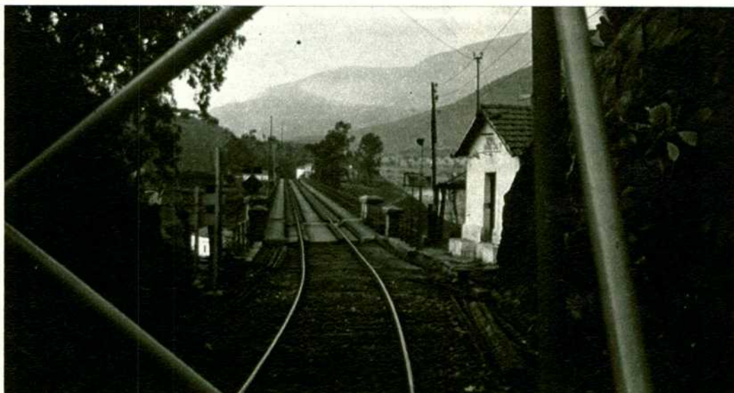
El puente internacional sobre el río Agueda desde la dresina de comprobación de espacio libre.
