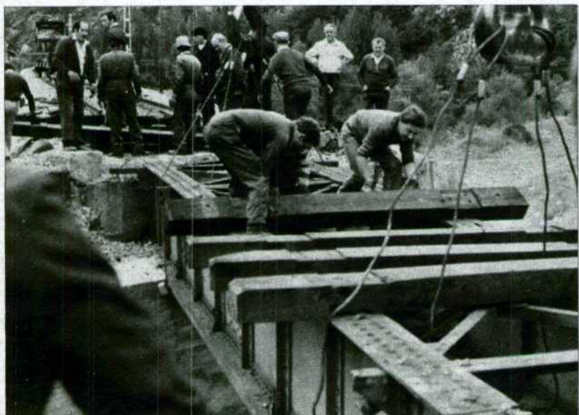
Quitando vía y traviesa del puente viejo.
