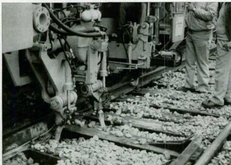
El operario que dirige la nivelación se coloca a 100 m. de la máquina sobre el rail exterior de la vía general.
