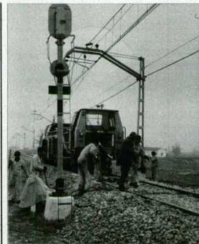
La brigada de RENFE retira las protecciones de las balizas del ASFA y descubre las conexiones eléctricas de las señales.
