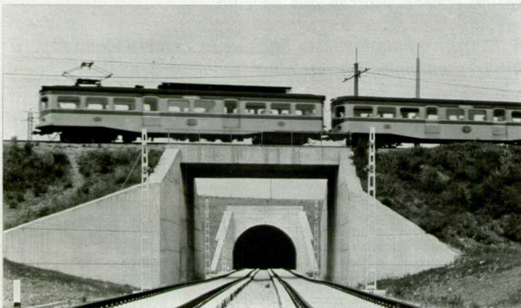
Un tren de los Ferrocarriles de la Generalidad atraviesa uno de los puentes bajo los que pasa la nueva línea.
