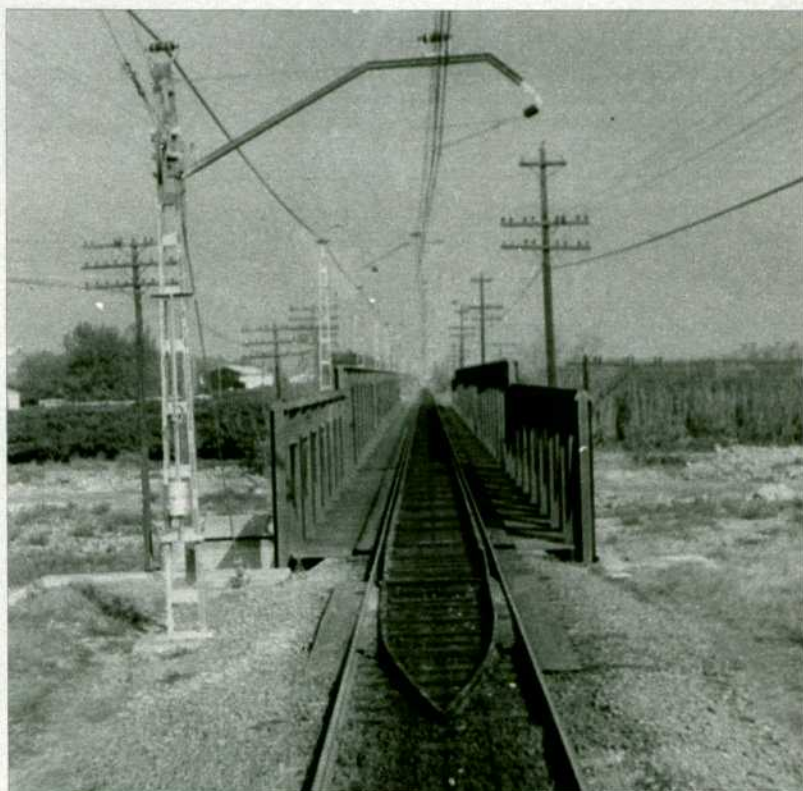
Ya en noviembre de 1973 estaban preparadas las pilas para el desdoblamiento de vías en el puente sobre el Mijares.
