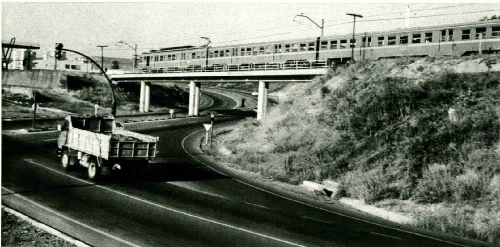
UT 440 de la línea Sevilla-Huelva en el paso sobre la carretera N-630 de la Ruta de la Plata, a la entrada de Camas.
