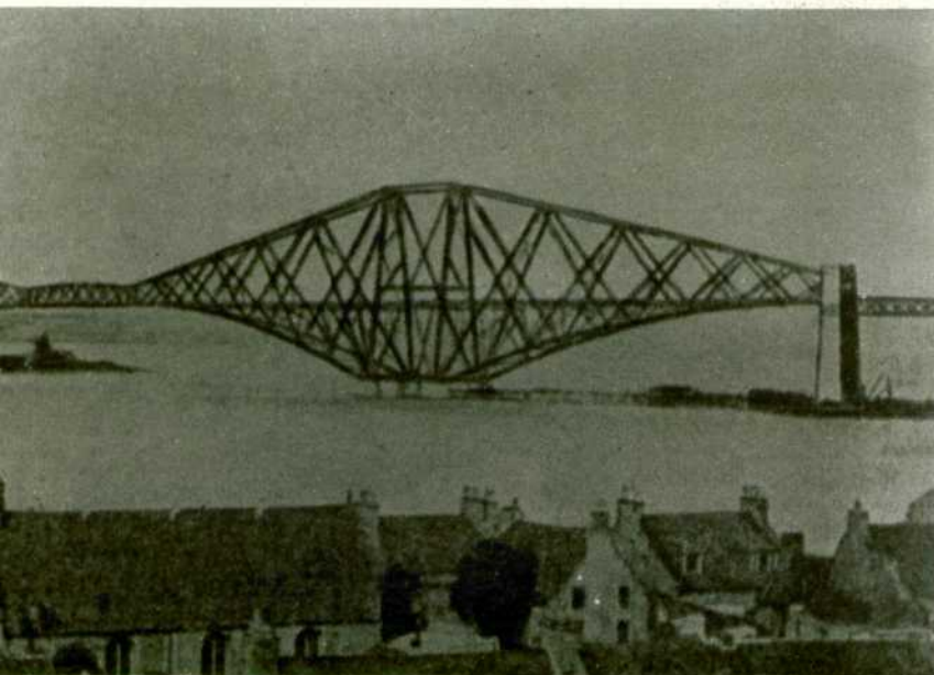
Pero, probablemente, el puente ferroviario más famoso del mundo sea el del Firth de Forth, en Escocia. Proyectado por John Fowler y Benjamin Baker, fue construido por William Arrol. Las tres torres del sistema Cantilever tienen una altura de 110 metros, y la línea de doble vía pasa a 47,500 metros sobre el nivel del mar. Las dos vigas mayores tienen 521 metros, y la longitud total del puente es de 2.528 metros. Las obras se iniciaron en 1882 y se concluyeron en 1889. El primer tren que cruzó por él lo hizo el 22 de enero de 1890. El Firth de Forth es, sin duda, uno de los símbolos más impresionantes del ferrocarril. (Fotos: Archivo SANZ.)
