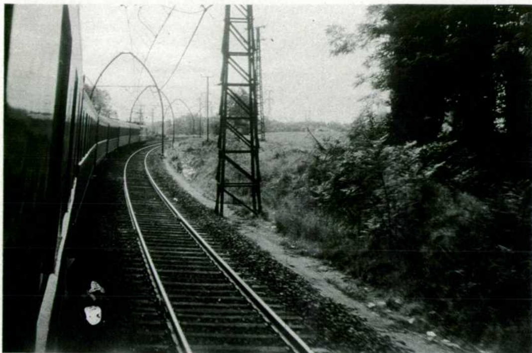
Catenaria suspendida de arcos de herradura entre Bordeaux e Irún.
