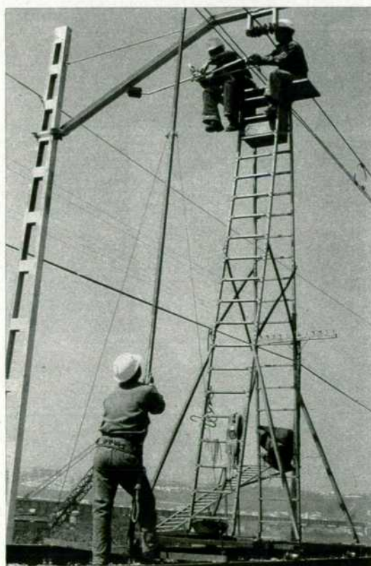
Comprobación de la altura de los hilos de contacto a la entrada de un punto singular.
