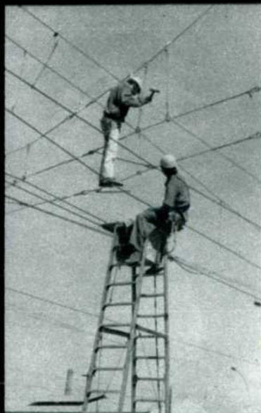
Montaje de transversales en la estación de San Jerónimo.
