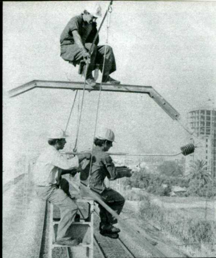
Montaje del equipo de ménsulas entre San Jerónimo y Sevilla-Plaza de Armas.
