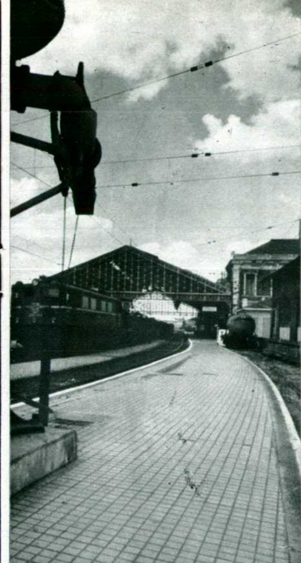
Antigua aguada para locomotoras de vapor.
