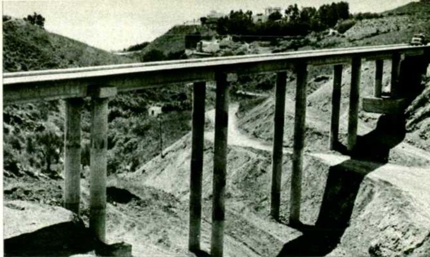
Viaducto de Arroyo Hondo, de ocho vanos.
