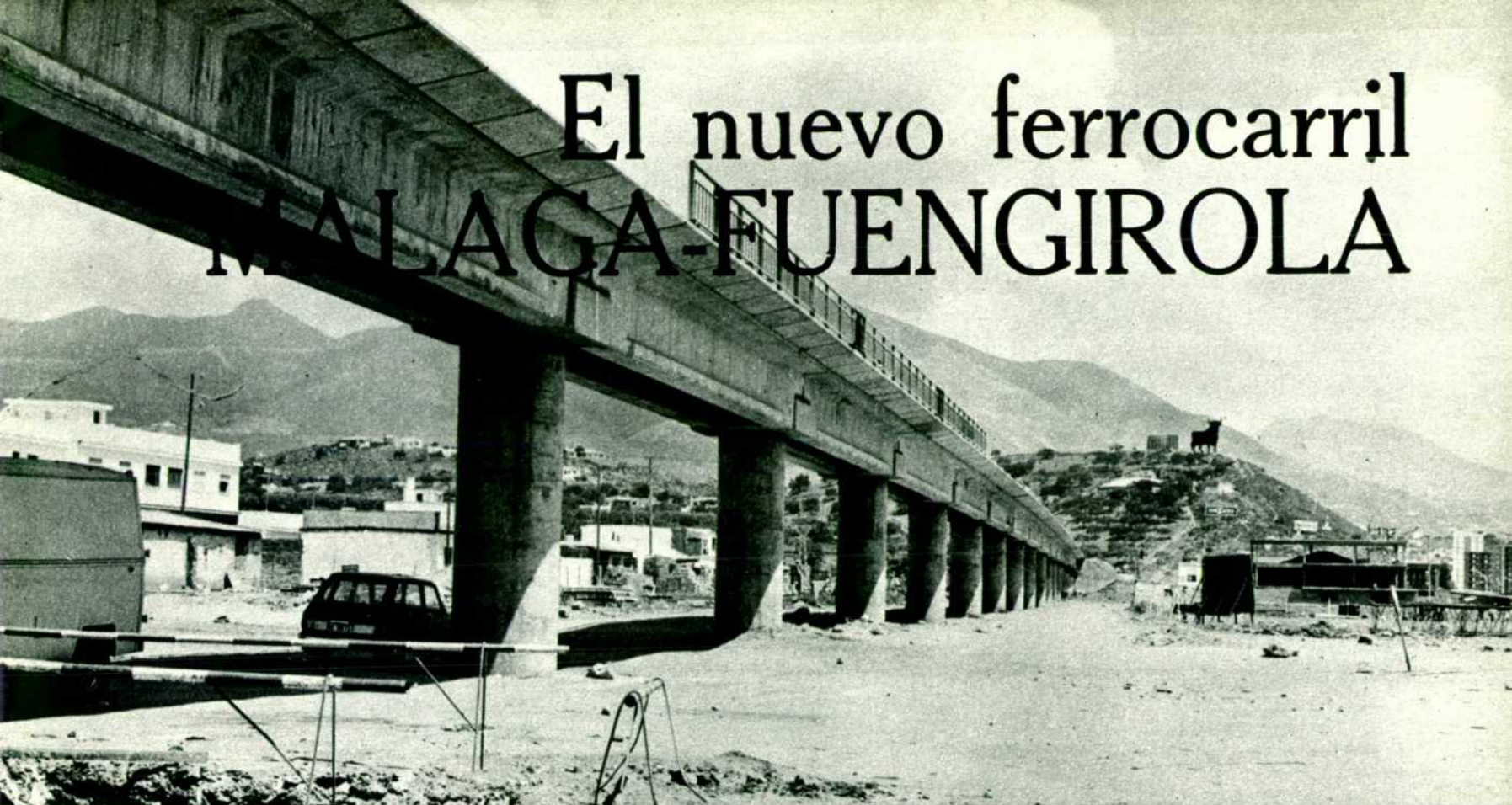
Viaducto de los Boliches, sobre los mayores pilotes clavados en tierra en todo el mundo.
