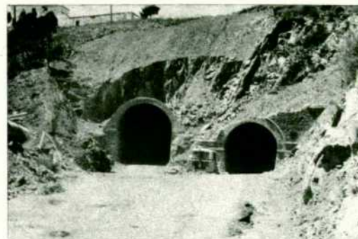
Los túneles nuevos han sido construidos paralelos a los antiguos.
