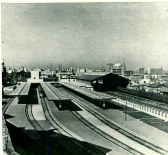
Nueva estación de Cádiz.
