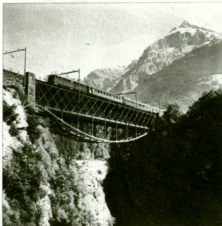
Viaducto de la Reuss d'Intschi, cerca de Amsteg.
