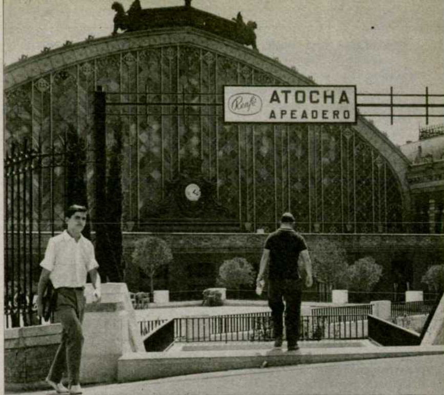
Entrada al apeadero de Atocha. Al fondo la estación.
