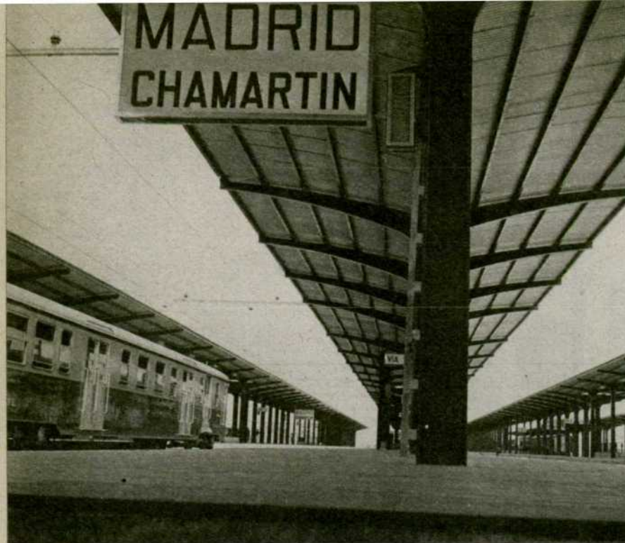
Uno de los andenes de la estación de Chamartín.
