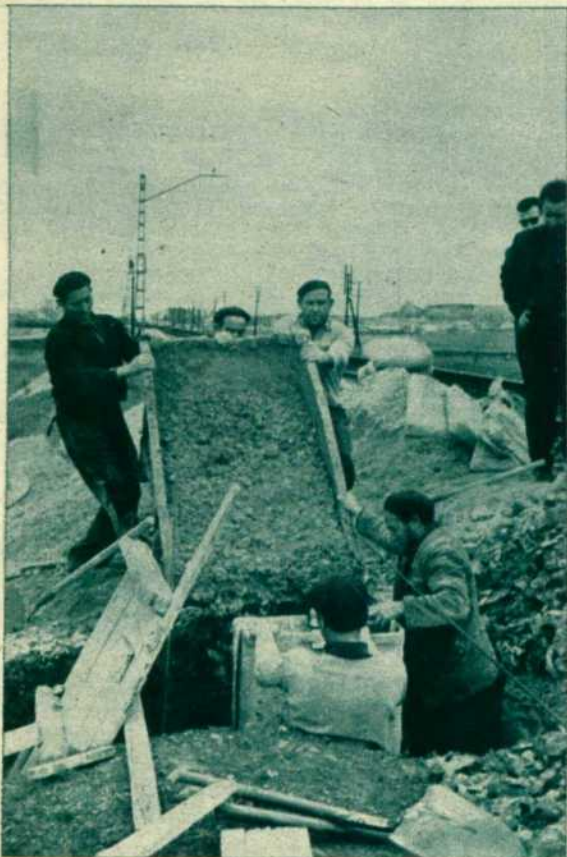
Hormigonado de postes
