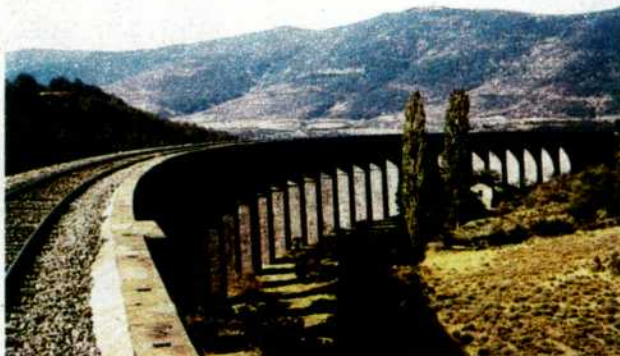
Viaducto de 28 arcos de Cénarbe.
