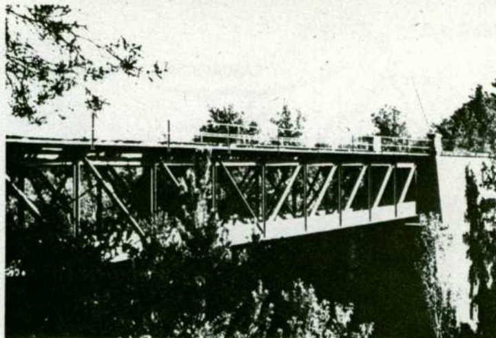
Estructura metálica sobre el río Aragón en el punto kilométrico 9/811. En Bedous, comienza la parte montañosa del tramo.
